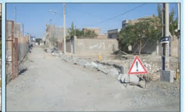
❁ اجرای جوبه و جدول خیابان بهمن ۱۳
