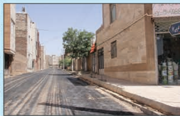
❁ زیرسازی و آسفالت خیابان حافظ و کوچه های منتهی
