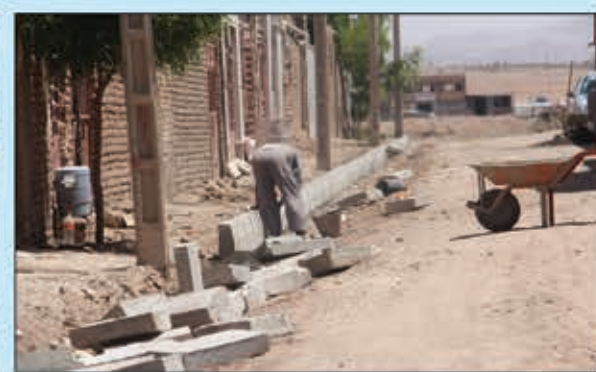
❁ اجرای جوبه و جدول خیابان حر دهلکوه
