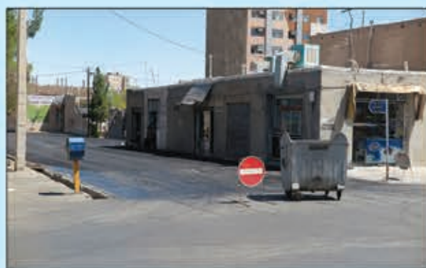
❁ زیرسازی و آسفالت خیابان مفتح
